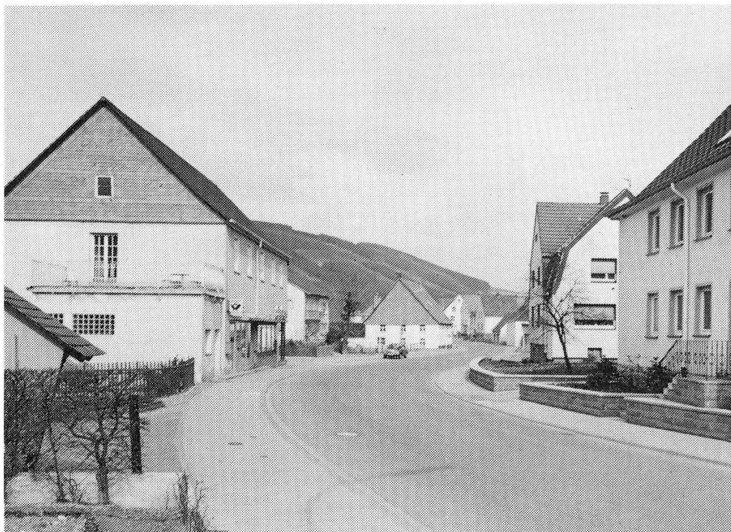
1982 Straßenbild am Samstagnachmittag bei ruhendem Autoverkehr. Niemand benutzt die Bürgersteige. Noch erhaltene Vorgärten haben keine Sitzplätze mehr.
