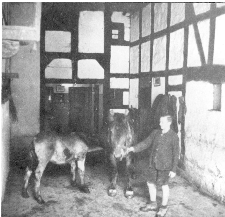
Abb. 27. Deele in Webers Haus. Dieser große Hof hat als einziger eine Scherwand aus älterer Zeit.
