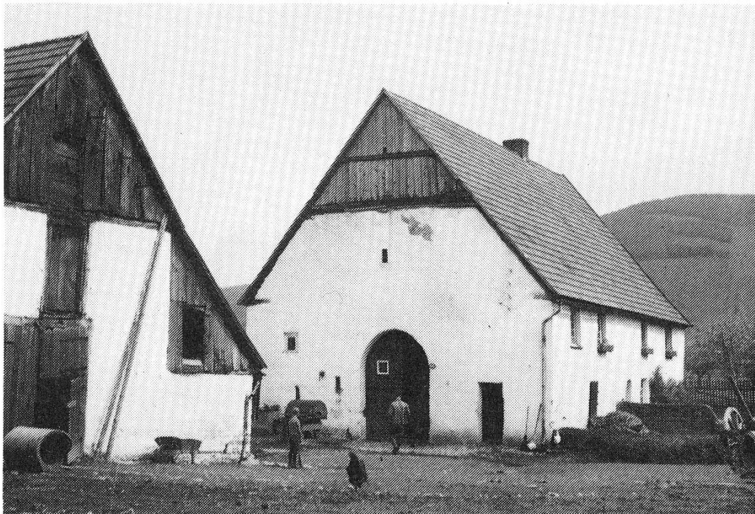
1937 werden die Gebäude noch landwirtschaftlich genutzt. Das Deelentor war Haupteingang, auch zur Wohnung im hinteren Teil des Hauses.
