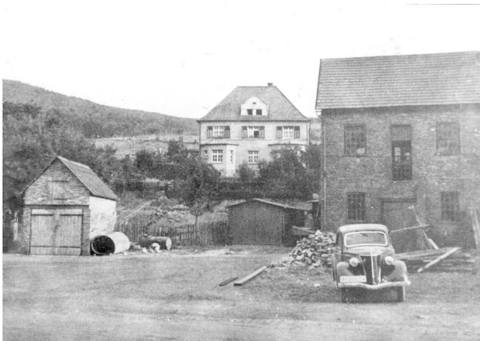
Abb. 5. Die „Villa“ mit Kettenfabrik und Autogaragen.
