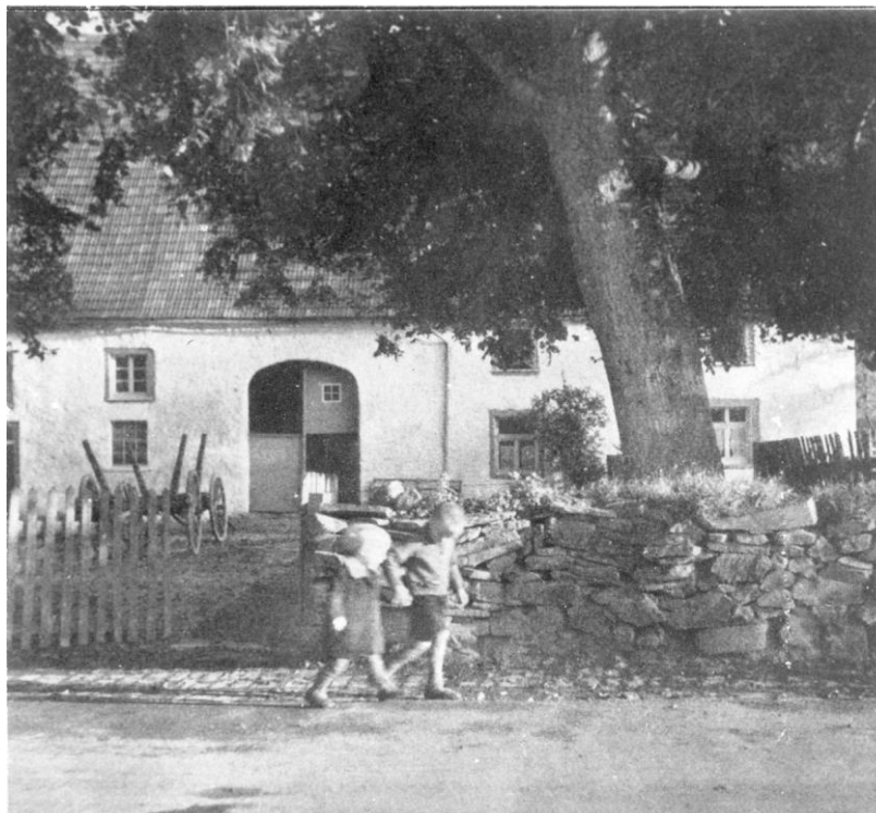
Abb. 11. Stracken Hof mit Trockenmauer als Abschluß. Das Deelentor ist 1854 an die Längsseite des Hauses verlegt worden und hat darum den Stichbogen und nicht mehr die alte Form.
