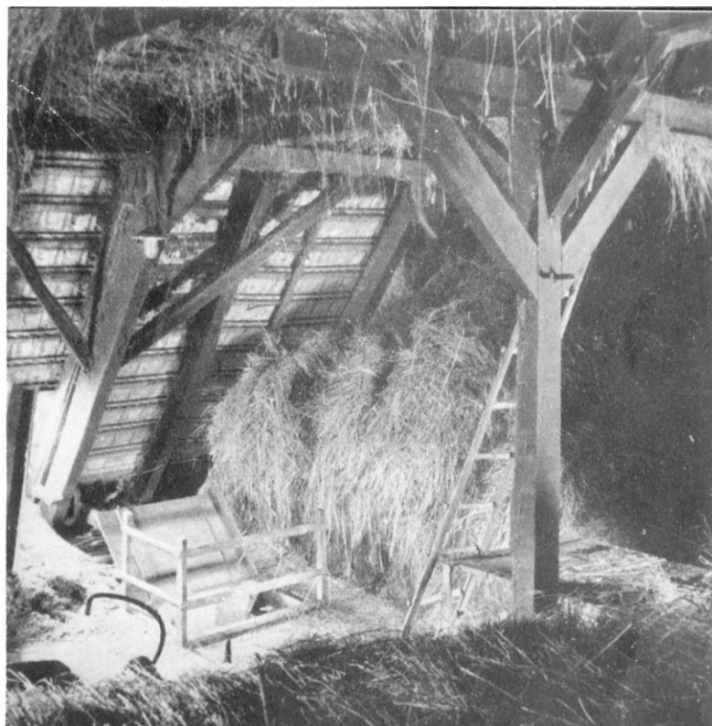
Abb. 25. Schlotmanns Hof, liegender Kehlbalkendachstuhl mit mittlerem Unterzug, wie er im alten Steinhaus öfter vorkommt.
