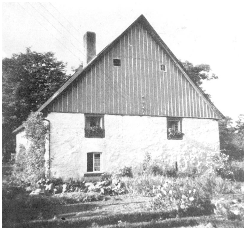
Abb. 15. Besten Haus von der Gartenseite her. Im Obergeschoß alte Fenster.
