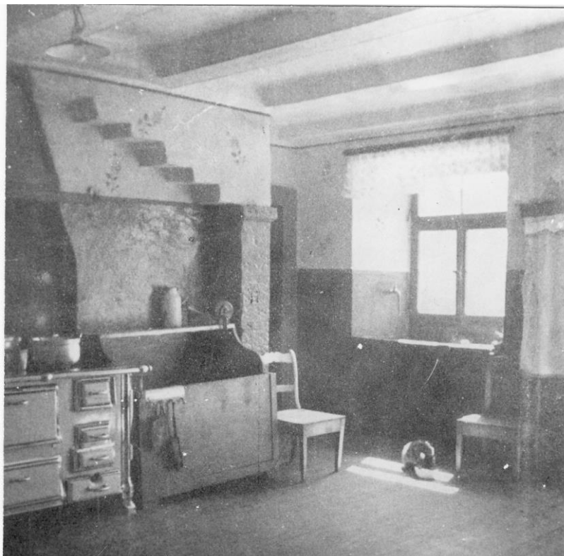
Abb. 29. Küche in Müllers Haus. In der alten Feuernische steht der moderne Herd, daneben der große Holzkasten. Vor dem Fenster ist in die dicke Wand der Spülstein eingelassen.
