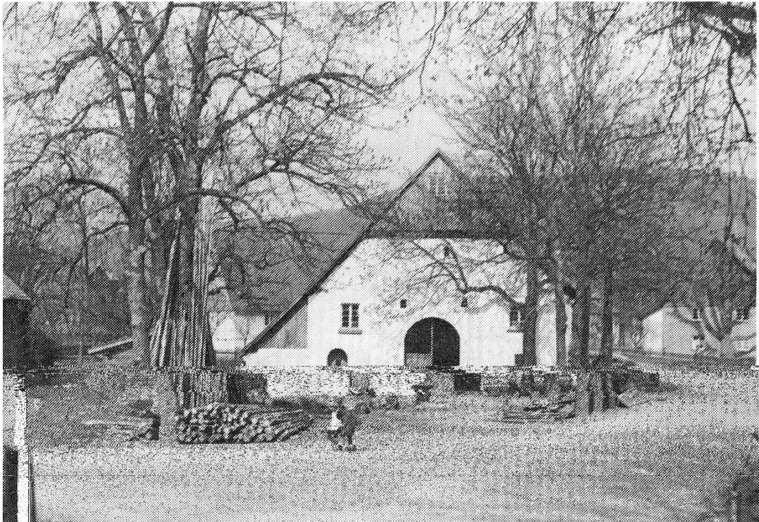
1937 fallen Wirtschaftsseite und Schauseite noch zusammen, über die Deele betritt man die Wohnung. Rechts neben dem Tor die Feierabendbank. Der Hofraum genügt für Pferdefuhrwerk und Holzlagerung
