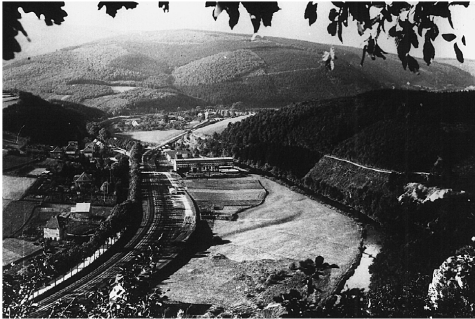
Die Biggetaler Eisenwerke im Tal der Bigge gegenüber der Hustert, von der "Hohen Ley" aus gesehen.
