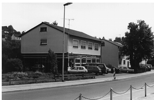
Die Sparkasse in ihrem Ursprungsgebäude von 1966.
