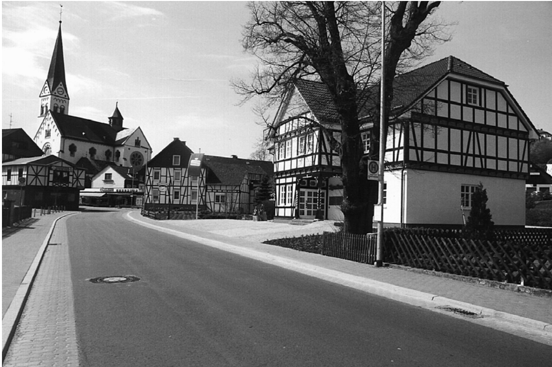
Das Sparkassengebäude (hinter der Henzen Linde) nach seiner Renovierung im Jahre 1990.
